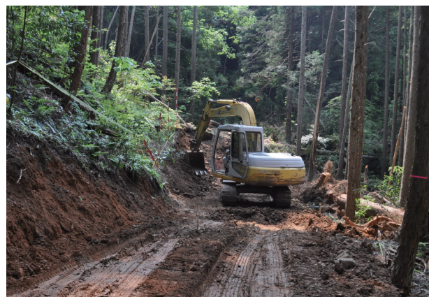
開設中の作業道
