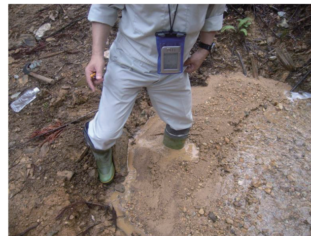
土砂を捕捉した沈砂池
