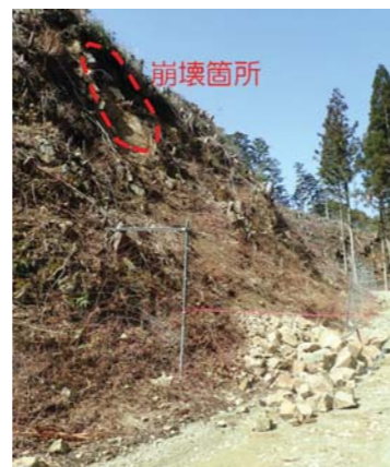
図4 崩壊した土砂により破損した防鹿柵
