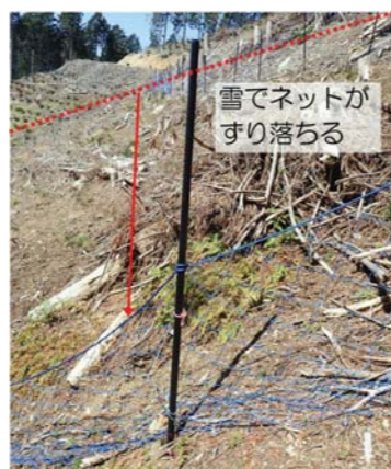
図3 積雪によりネットがずり落ちた防鹿柵
