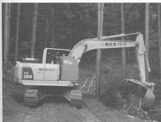
写真一五 ストレンジャー付きバケットによる道づくり
