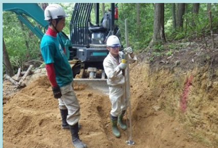
壊れにくい森林作業道作設技術の開発
