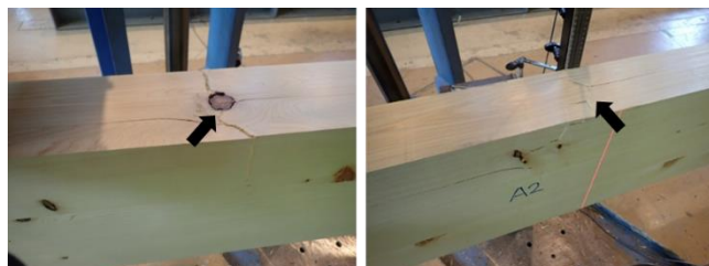
図-2. 試験体の破壊性状（上面圧縮側の圧縮破壊）
