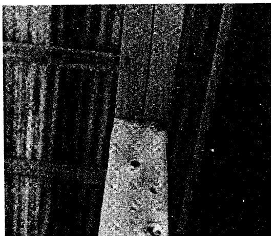
図-5 桁の割れ
