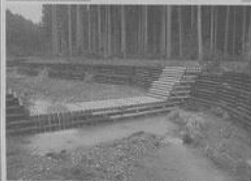
施工された木製治山ダム
