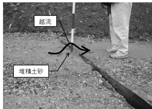
図-1 排水処理施設が適切に機能していない事例
